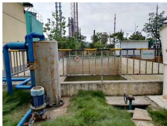
初期雨水收集池
